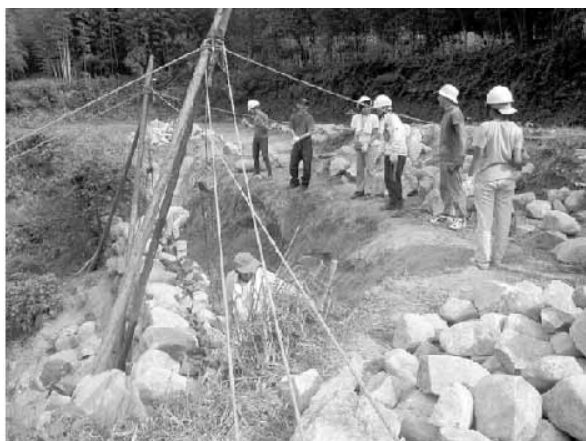
石積み修復風景
