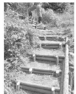
完成した階段工
