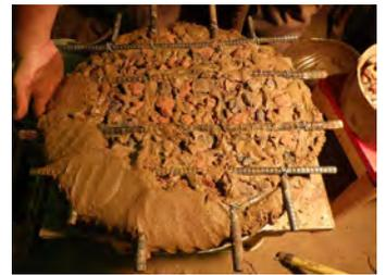
⑫筋金の隙間に焼真土を詰め込み、荒土を付ける
