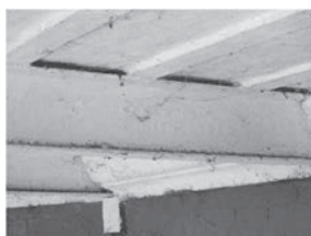
写真 4 正面玄関天井梁 2
