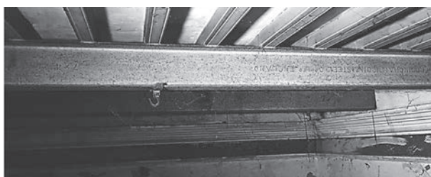
写真 1 建物番号 34 に天井梁として使用されている Frodingham 社製の I 形鋼 （上下逆さで、右の方に社名・左の方に 7×4 の刻印がある）
