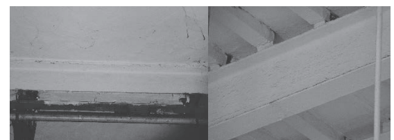
写真30 天井梁(Frodingham) 写真31 天井梁(Dorman Long)
