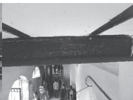
写真 7 ピロティ天井梁
