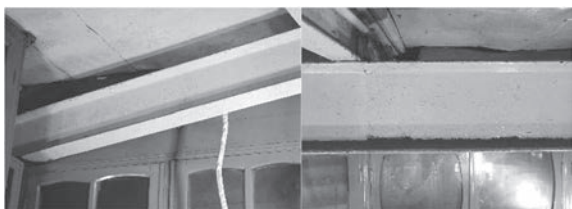
写真18 天井梁(Frodingham) 写真19 天井梁2(Frodingham)
