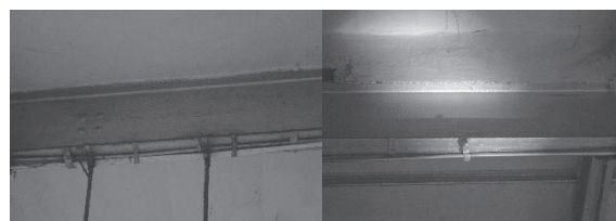
写真24 天井梁(Tata) 写真25 天井梁(Frodingham)
