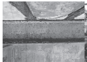
写真 12 右翼室天井梁 (Frodingham)
