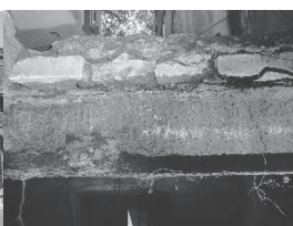
写真 11 室内階段梁 (Cargo Fleet)
