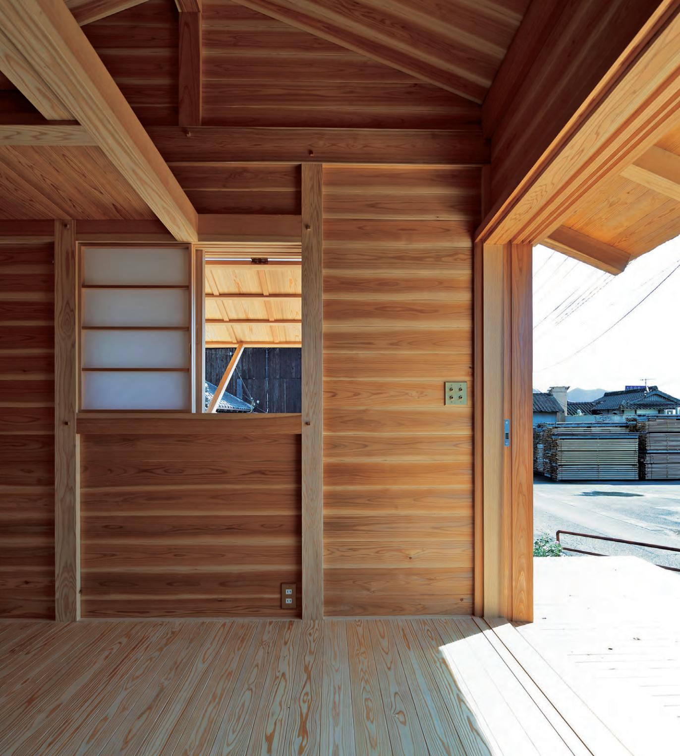
内部の柱は板目使い、壁板は源平材、床は白太の浮づくり。
